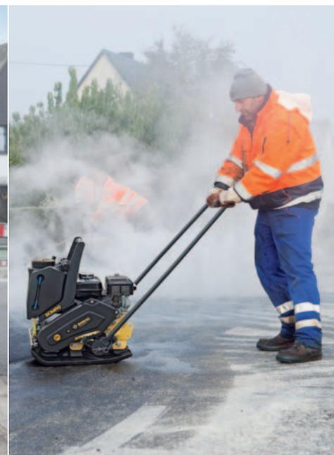
BP 12/50 A mit spezieller Grundplattenform: Wenden ohne die Oberfläche zu beschädigen.
